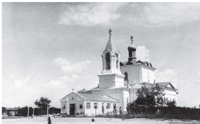
Никольская церковь. г.Оренбург
