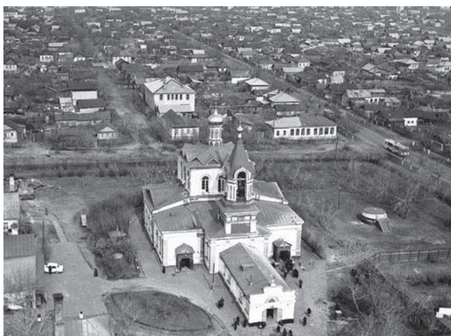
Никольская церковь. г.Оренбург
