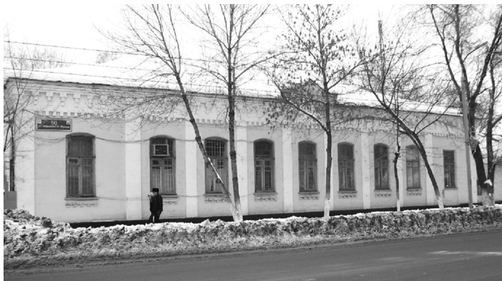
Здание бывшей церковно-приходской школы Оренбургского Успенского женского монастыря (современный вид с ул. Маршала Г. К. Жукова).
