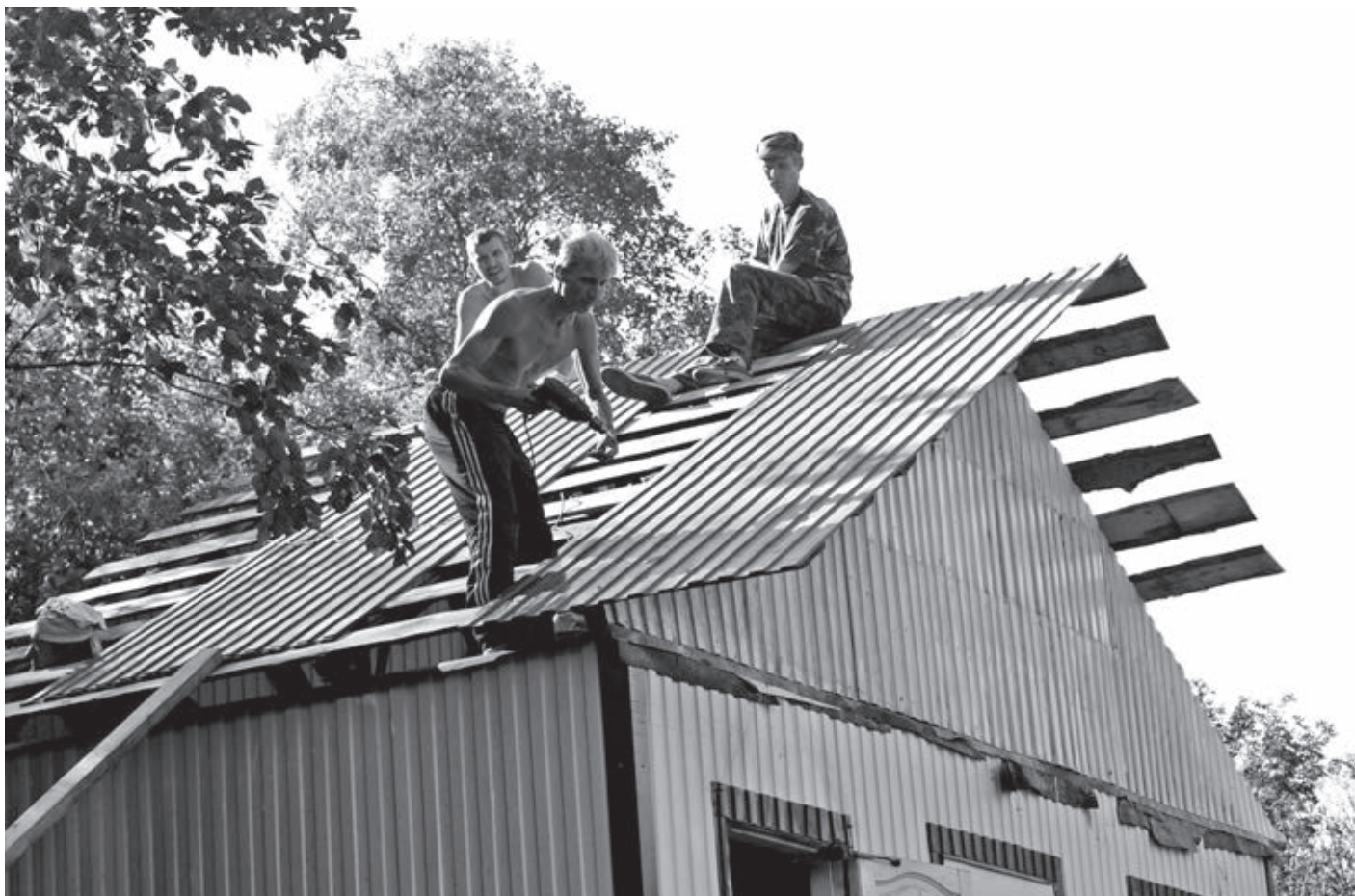
Строительство общего дома в экопоселении «Природное». 2012 г.
