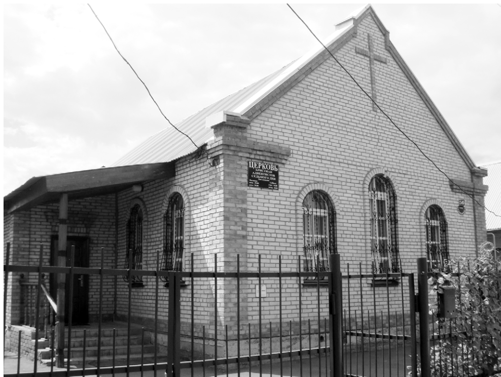
Молитвенный дом общины АСД № 1 г. Орск на ул. Луначарского
