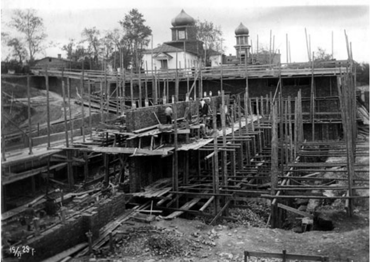
Строительство электростанции на территории Богодуховского монастыря. 1929 г.
