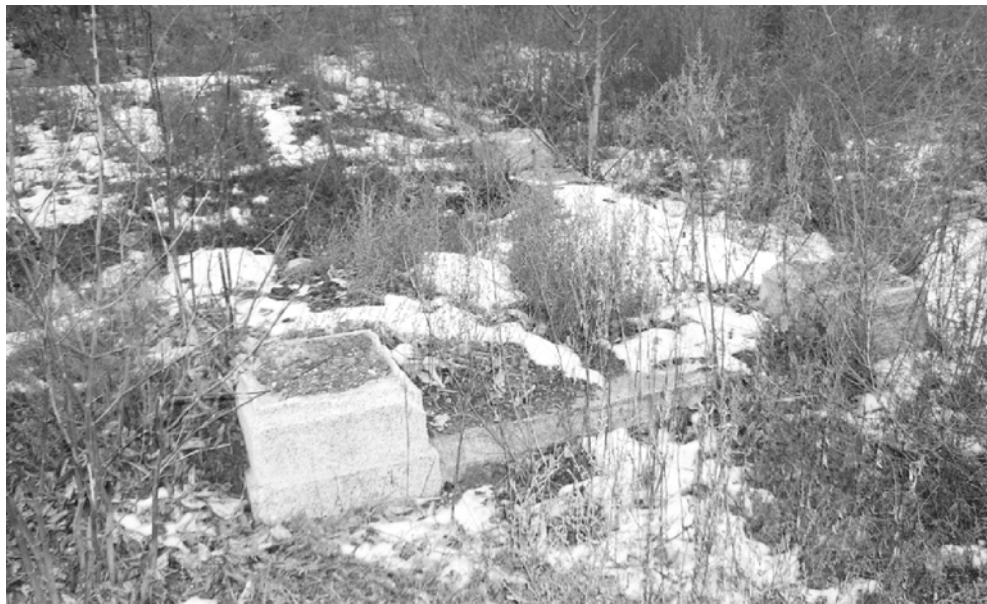
Фрагмент остатков основания часовни над фамильной усыпальницей Холодковских.
