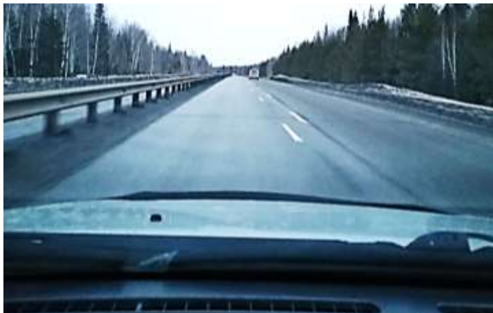
Рисунок 3.5 – Осмотр проезжей части
